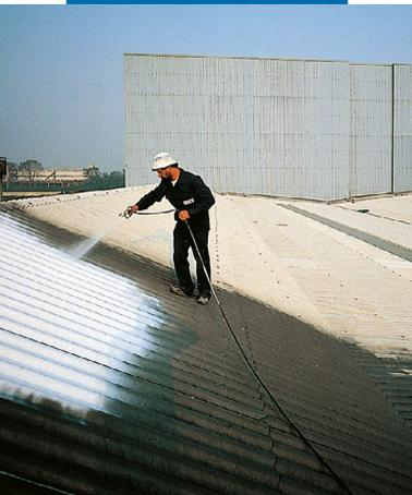
Aplicação do Aquaflex por pulverização sobre cimento-amianto ondulado tratado com Malech
