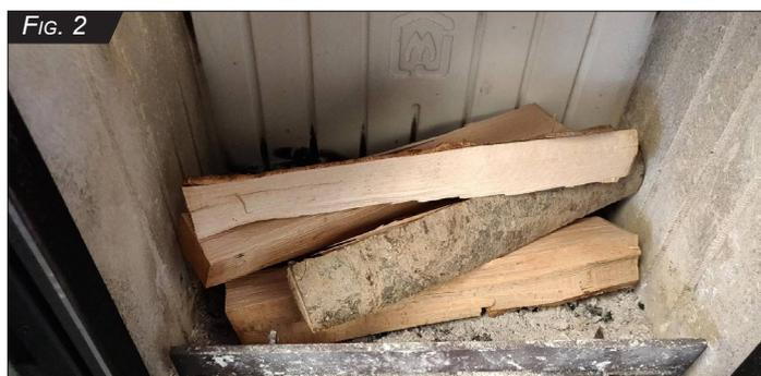
Una vez terminada la primera carga se puede cargar leña en las cantidades indicadas al final del apartado b) y siempre centrada con respecto al plano de fuego paralelamente a la pared posterior.
