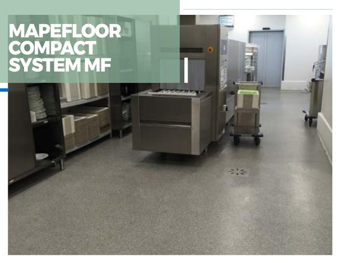
Sistema epoxídico decorativo multicamadas, de elevado valor estético, para a realização de pavimentos industriais e comerciais numa espessura de 2,5-3,0 mm.
