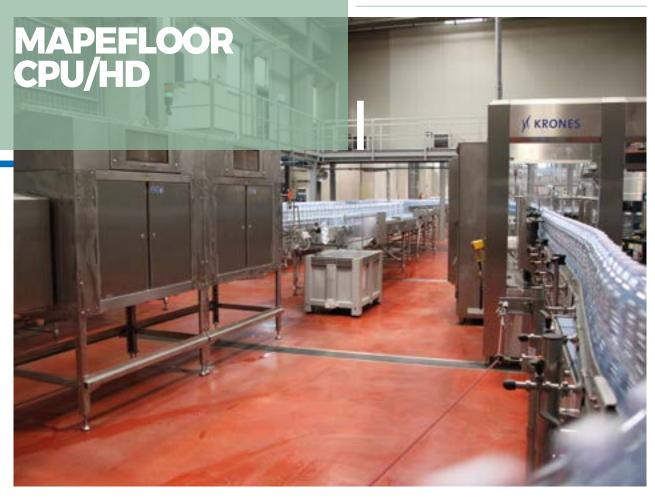
Sistema à base de formulado poliuretano-cimento, de elevada resistência química, mecânica e aos choques térmicos, para revestimentos antiderrapantes de pavimentos industriais numa espessura compreendida entre 6 e 9 mm. Conforme as normas para a utilização em ambientes alimentares.
