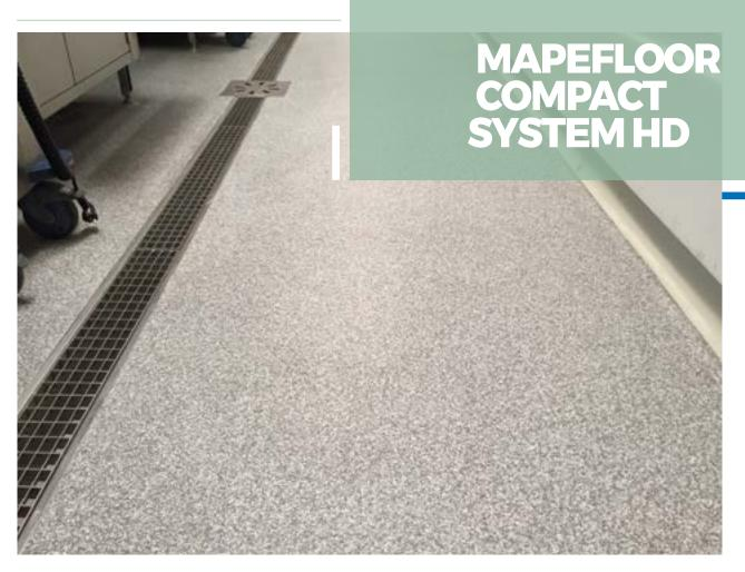
Sistema epoxídico em betonilha de argamassa resinosa de poro fechado, de elevado valor estético, para a realização de pavimentos industriais e comerciais numa espessura de 5,0-8,0 mm.
