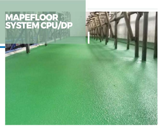
Sistema multicamadas antiderrapante à base de formulado poliuretano-cimento, de elevada resistência química e mecânica, para revestimentos de pavimentos industriais numa espessura compreendida entre 3 e 4 mm. Conforme as normas para a utilização em ambientes alimentares.
