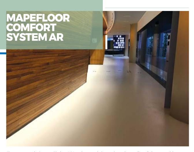
Sistema autonivelante, elástico, UV resistente, à base de resina poliuretânica aromática, para revestimentos de ambientes interiores, de 2 mm de espessura.
