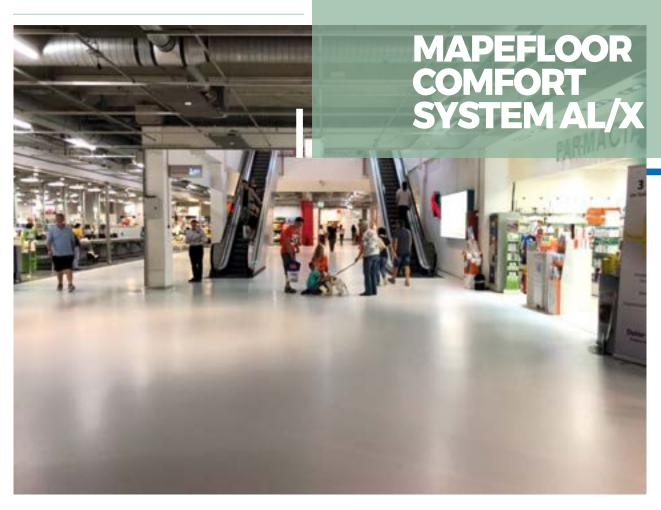
Sistema autonivelante, elástico e flexível, UV resistente, à base de resina poliuretânica alifática, para revestimentos de ambientes civis, de 6 mm de espessura.
