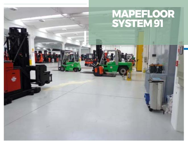
Sistema epoxídico em argamassa espatulada para pavimentos industriais, ótimo para a recuperação de pavimentos velhos de 6 a 15 mm de espessura.
