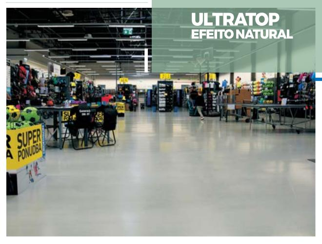
Sistema cimentício autonivelante, de endurecimento ultrarrápido, para realizar pavimentos resistentes à abrasão numa espessura compreendida entre 5 e 40 mm.
