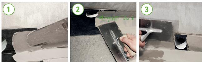
2 Fixar o Aquastop 70 sobre o impermeabilizante fresco seguindo a junta parede-pavimento. Exercer uma forte pressão e alisar para garantir a colagem total do Aquastop 70, evitando a formação de pregas na banda.
