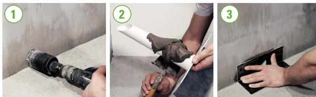
2 Utilizar o Keralevel® Eco LR para a fixação provisória e o enchimento: aplicar o nivelante sobre o tubo de saída do Aquaform OD e na eventual reentrância na betonilha.
