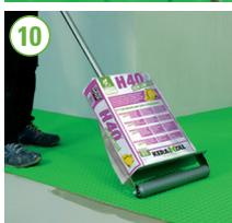
8 Pressionar imediatamente as telas sobre o adesivo fresco utilizando o Aquaform R carregado com um saco de adesivo.
