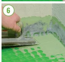
3 Aplicar o selante Aquastop Fix na parede e sobre a membrana com a espátula lisa, tendo o cuidado de preencher as cavidades circulares.
