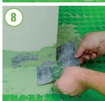
5 Selar a sobreposição das duas bases utilizando o Aquastop Fix.
