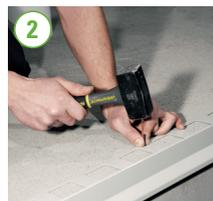
3 Fixar os perfis de modo a obter uma junta com cerca de 5 mm entre peças adjacentes e entre o perfil e as peças angulares. Posicionar o Aquaform DL para cobrir a junta entre os perfis.
