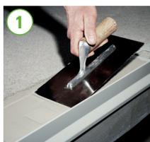
2 Aplicar as bandas sobre o impermeabilizante fresco seguindo o rebordo vertical da pingadeira. Exercer uma forte pressão e alisar para garantir a colagem total das bandas, evitando a formação de pregas na banda.
