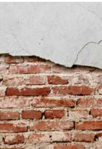
As alvenarias são todas potencialmente absorventes e sofrem o contacto com a água. Em particular, a humidade mais crítica é aquela proveniente do solo carregada de sais (cloretos, sulfatos, nitratos), que impregnam a alvenaria e causam ascensões capilares de humidade até alguns metros.
