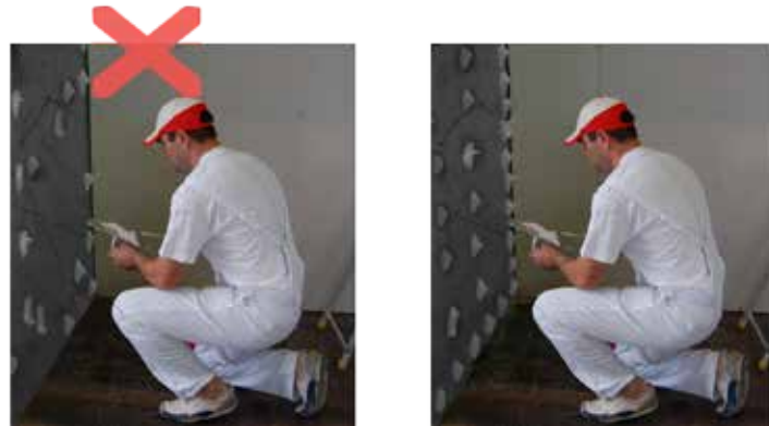
Figura 88: Aplicação da cola.
