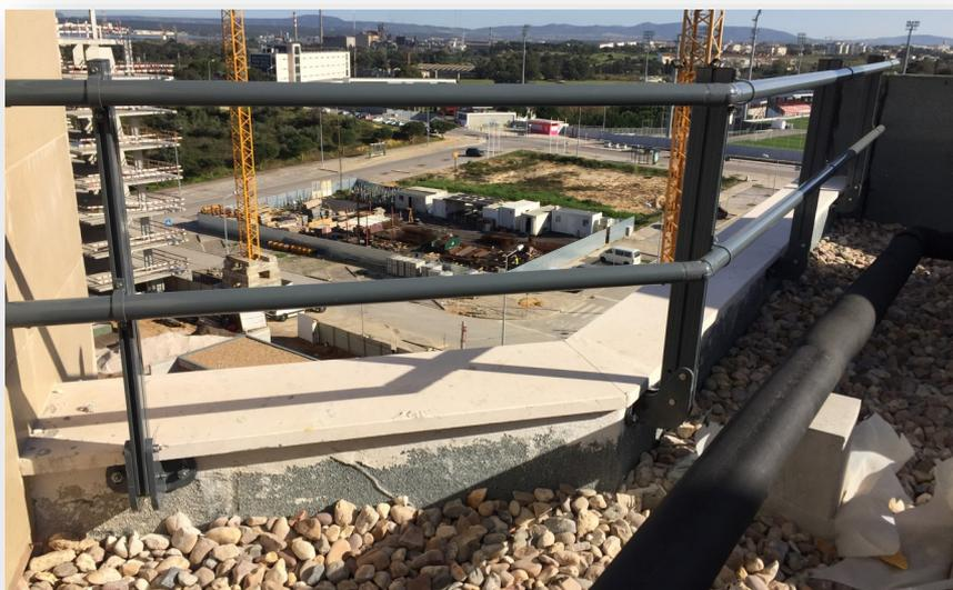
A guarda SG.PR.V permite a proteção coletiva permanente em locais técnicos não acessíveis ao público. Este sistema dispõe de diferentes bases que permitem a adaptação da guarda consoante as condicionantes técnicas do local (geometria do murete, resistência para fixação, existência de impermeabilização e/ou de isolamento térmico).
