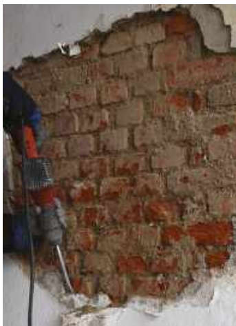
Remover rebocos degradados
