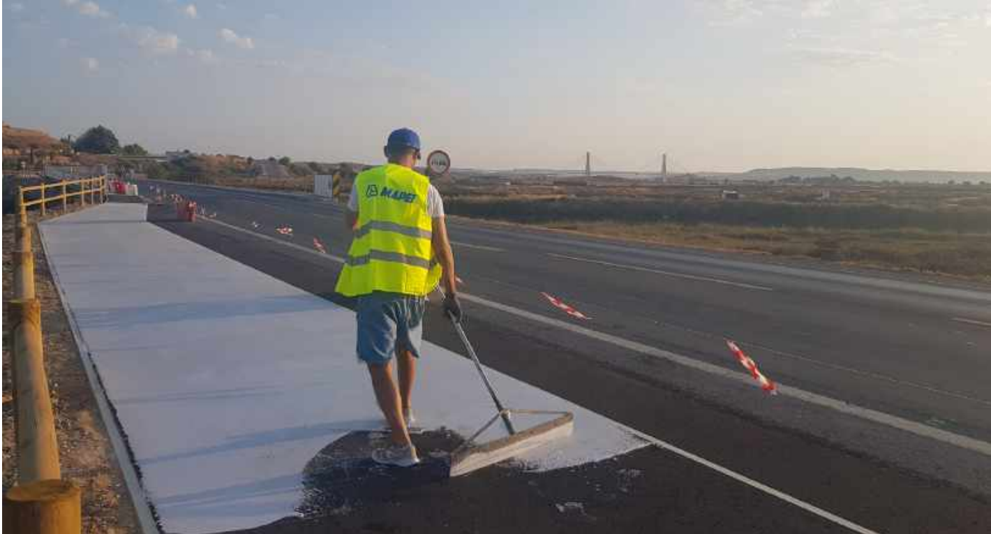
EM CIMA. Aplicação do produto Mapecoat TNS White Base Coat ABAIXO. Aplicação do produto Mapecoat TNS Race Track Dark Green TNS
