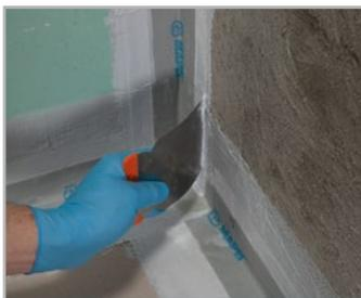
Impermeabilização dos cantos internos mediante aplicação de MAPEBAND PE 120 e peças especiais
