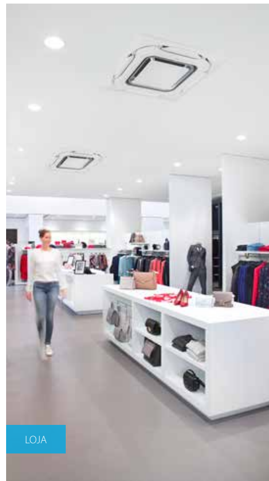
Cassete "Round Flow": Descarga de ar de 360° para um nível mais elevado de eficiência e conforto
