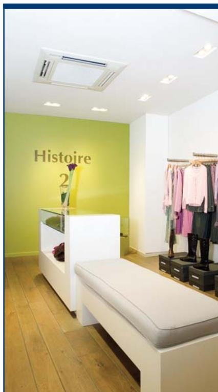
Caixa instalada no tecto com insuflação em 4 direcções
