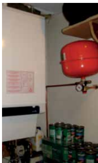
Figura 33: Imagem do módulo de bomba de calor e caldeira a gás híbrido interior (configuração de teste no terreno).
