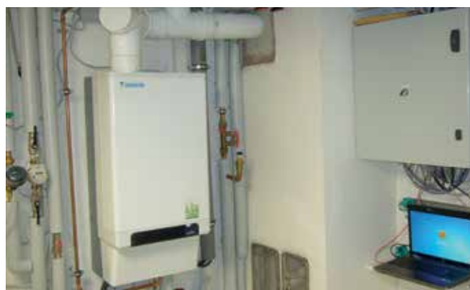
Figura 38: Imagem da unidade interior da solução híbrida instalada.
