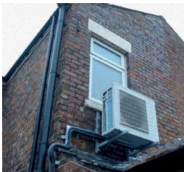
Figura 32: Imagem do módulo de bomba de calor híbrida instalado.
