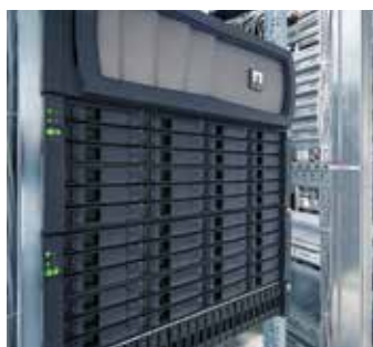
Centros de telecomunicações
