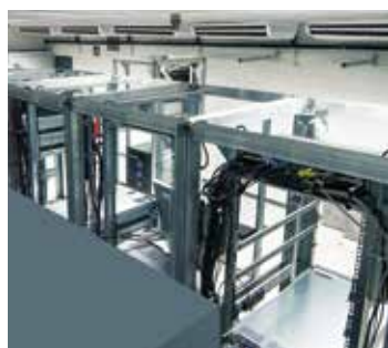
Salas de servidores
