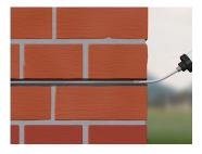
O tubo de injeção deve ser retirado lentamente injetando o Silitop Water Stop no buraco. Se existirem depósitos de creme devido a uma possível sobredosagem ou acumulação em torno do furo, pode remover o mesmo, usando um pano absorvente.
