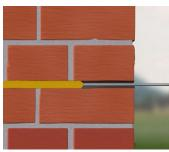
Selar os orifícios com argamassa da gama da Topeca, diretamente sobre o furo. Caso seja necessário regularizar a parede tratada utilizar o Topeca Sane.
