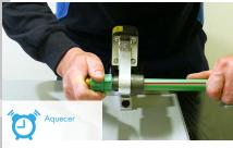
Quando a matriz estiver quente, coloque o acessório e o tubo nas duas extremidades. Aqueça de acordo com o tempo indicado na tabela de trabalho. Evite o aquecimento excessivo.
