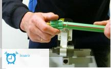
Após o tempo de aquecimento necessário, insira rapidamente o acessório no tubo pressionando levemente e aguarde o tempo indicado na tabela de trabalho para arrefecimento.
