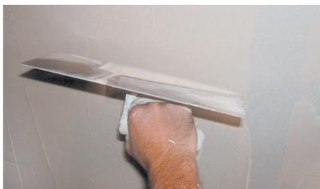
2. Aplicar uma ou várias camadas com a ajuda de uma espátula ou liçosa. Poderá ser aplicado em diversas camadas cruzadas. O tempo de espera entre cada camada depende: da temperatura e humidade ambiente, do tipo de suporte, da espessura da anterior.
