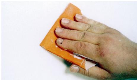
3. Depois de seco, aperfeiçoar a superfície com uma lixa. Passados 2 a 3 dias poderá revestir com tinta ou papel.
