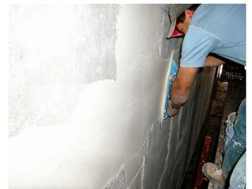
O acabamento liso é conseguido passando uma talocha metálica sobre o Rebetop Kal Color Liso.
