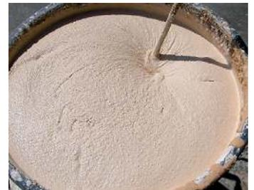
Molhar a parede e esperar que o filme desapareça antes de aplicar a 1ª camada com uma talocha inox. Regularizar a superfície, apertando bem a massa contra o suporte.
