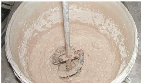
1. Verter o pó progressivamente em cerca de 7,5 litros de água limpa e deixar repousar entre 2 a 3 minutos. Misturar mecanicamente com misturador de velocidade baixa (500 rpm) de forma a obter uma pasta homogénea e com consistência plástica.
