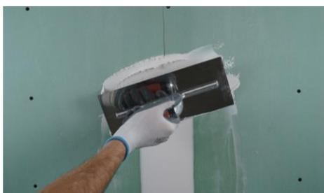
3. Para bandas de papel ou rede não adesiva, barrar as juntas entre as placas. Aplicar a banda sobre Tuforte Juntas. O friso da banda é colocado na junção das duas placas. Comprimindo-as bem.
