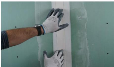
5. Recobrir a banda com uma nova camada de Tuforte Juntas e deixar endurecer. (Nível de Acabamento Q1)
