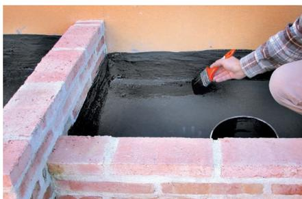
1. Misturar bem o Topeca dry. Comece por aplicar um primário com Topeca dry diluído com água (cerca de 2/3 de Topeca dry : 1/3 água).
