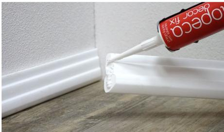
1. Cortar o bico do cartucho e da ponteira num ângulo de 45°, no tamanho e espessura desejada. Enroscar a ponteira no cartucho e colocá-lo na pistola aplicadora (pneumática ou manual)
