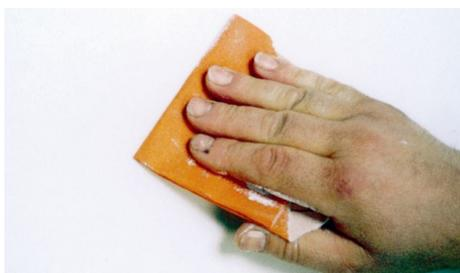
3. Depois de seco, se necessário aperfeiçoar a superfície com uma lixa. Passados 2 a 3 dias poderá revestir com tinta ou papel.
