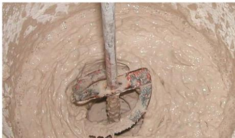
1. Verter o pó progressivamente em cerca de 10 litros de água limpa e deixar repousar entre 2 a 3 minutos. Misturar mecanicamente com misturador de velocidade baixa (500 rpm) de forma a obter uma massa de consistência plástica. Se necessário ajustar a consistência da pasta adicionando pó ou água. A consistência depende dos trabalhos a realizar, isto é, pasta mais dura para pequenas regularizações ou mais fluida/cremosa para acabamentos.
