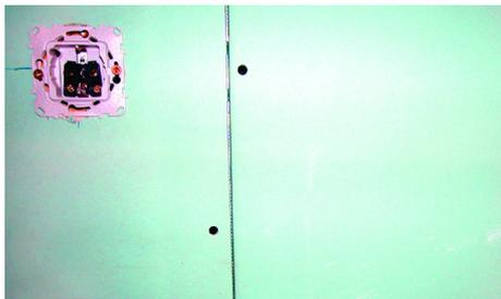
A superfície deve estar limpa, seca, sem pó ou qualquer outro material que prejudique a normal aderência. Verificar se as cabeças dos parafusos estão corretamente embutidas. Os suportes devem apresentar-se planos. Em suportes pintados, remover toda a tinta solta e sem aderência, limpar corretamente a superfície.
