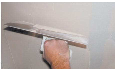
2. Aplicar uma ou várias camadas com a ajuda de uma espátula ou talocha metálica. Poderá ser aplicado em diversas camadas cruzadas. O tempo de espera entre cada camada depende: da temperatura ambiente, do tipo de suporte, e da espessura da camada anterior.
