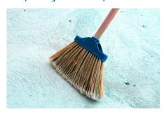
A betonilha deve ser rica em cimento (traço volumétrico indicativo, 1 Cimento: 3 Areia lavada) ou betonilha Cem, ter humidade superficial, de forma a permitir a correta molhagem do Topeca Endur Classic. A betonilha deve ser dimensionada de forma a apresentar a espessura adequada à utilização prevista.
