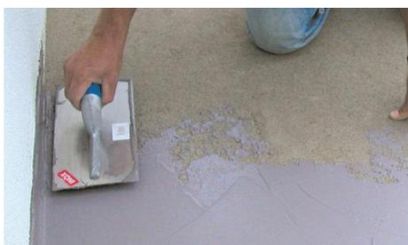
3. Aplicar a 2ª camada com a parte dentada da talocha, o que permite regular a espessura de material aplicado. De seguida alisar com a parte lisa da talocha. Deixar endurecer (cerca de 4-5 horas). A espessura preconizada para garantir a impermeabilização é de 2 mm.
