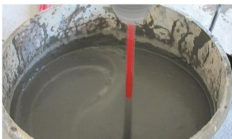
1. Misturar mecanicamente os 2 componentes (juntar o componente A ao componente B), com misturador à velocidade lenta, até obter uma pasta de consistência plástica e sem grumos.
