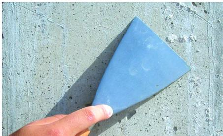
Os suportes devem estar resistentes e limpos, sem poeiras, óleos descofrantes, ferrugem. Sondar com um martelo as superfícies a reparar. Eliminar as partes defeituosas, betão degradado ou tintas não aderentes, até alcançar suporte sólido.
