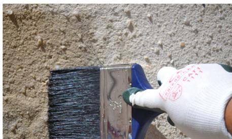
1. O Consolidante Topeca pode ser aplicado por pulverização, imersão ou pincel, de acordo com o objeto a ser consolidado. As áreas de maiores dimensões devem ser tratadas com equipamentos de pulverização.
