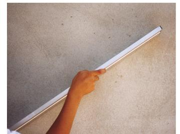
Não deve proceder ao acabamento da superfície com o reboco demasiado fresco, principalmente se for para talochar, uma vez que esta operação poderá originar a movimentação da massa e conseqüentemente o aparecimento de fissuras.
