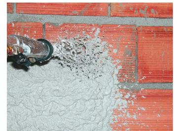
Após projecção, regularizar a superfície com régua de alumínio H fechado, de modo a obter uma superfície plana.
