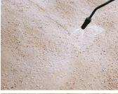
Após a presa da camada inferior do betão lavar a camada superficial com jato de água. Ajustar a pressão do jato de água de acordo com a superfície tratada.
