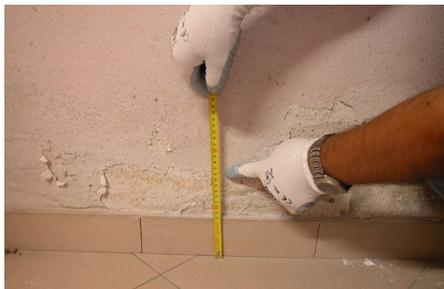
O reboco degradado, solto e com elevada carga de sais deve ser retirado por picagem até 50 cm acima da parte húmida visível. Em paredes intactas e sólidas não é necessário remover o reboco. Em condições normais a barreira capilar contra a humidade ascendente coloca-se 10-15 cm acima do nível do solo, tanto no interior como no exterior. A quantidade de Silitop Barreira a utilizar depende de vários parâmetros tais como: espessura e grau de humidade da parede e da porosidade dos materiais.
