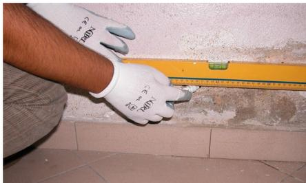
1. Com a ajuda de um nível e de uma régua marcar uma linha contínua à altura de 15 cm acima do solo. Sobre a qual serão indicados os pontos de perfuração afastados uns dos outros conforme distâncias apresentadas no quadro da preparação do suporte.
