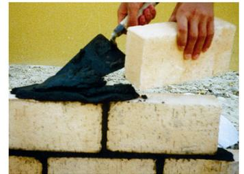
Regularizar as juntas à medida que a argamassa vai endurecendo, utilizando um ferro de juntas ou uma esponja húmida.
