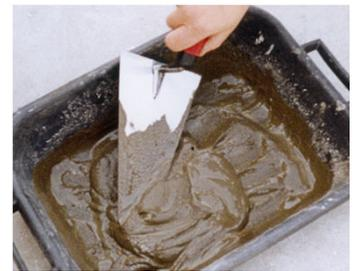
Aplicar a pasta em espessura regular e contínua. Colocar os elementos, comprimindo-os e ajustando-os.
