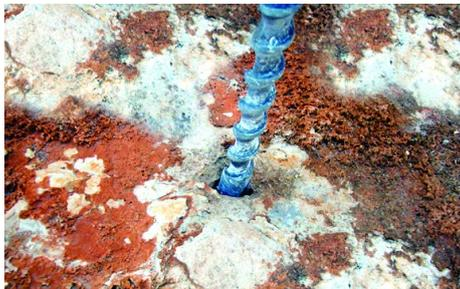
Fazer a perfuração com brocas de diâmetros adequados. O diâmetro ideal para furos é de 40mm.
