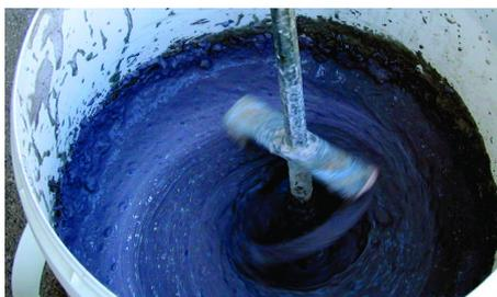
1. Misturar Topeca Dinamit com 25% a 28% de água (respeitar esta quantidade de água). A água a utilizar não deve estar a mais de 20°C. Misturar a massa até obter uma mistura fluida e sem grumos.
