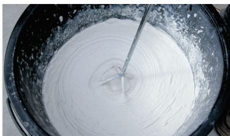
1. Misturar Topcola Flex Ultra com cerca de 8 litros de água por saco de 25kg, até se obter uma massa com consistência plástica.
