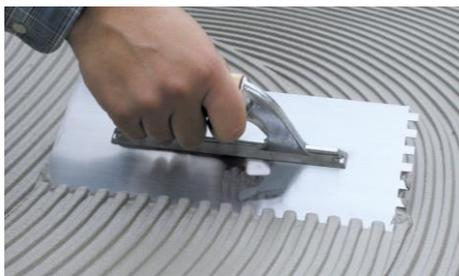
5. Aplicar o número de camadas suficientes de forma a obter uma espessura de 2mm de material. Caso pretenda revestir a superfície com cerâmica, a colagem poderá ser efetuada utilizando a Topcola Flex Record.
