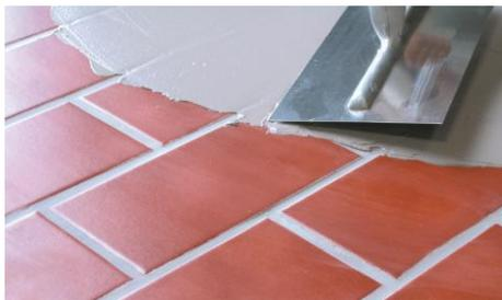
3. **Para impermeabilizar:** Aplicar uma 1ª camada de Topelast (A+B) sobre o primário com talocha lisa, pressionando bem o produto contra o suporte de forma a preencher todo e qualquer poro existente. Deixar endurecer.
