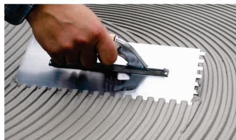
2. Aplicar Topcola Rápido sobre o suporte, em pequenos panos, regularizar a espessura com uma taloça dentada adaptada ao formato da peça.
