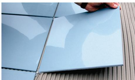
3. Colocar as peças sobre o cimento cola, pressionar (batendo-as fortemente) e movê-las (efetuar um ligeiro movimento perpendicular aos sulcos), de modo a conseguir o completo nivelamento dos sulcos e assegurar uma boa transferência da cola. Deixar juntas entre peças com largura adequada ao tipo de peça que está a colocar.
