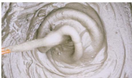
1. Misturar mecanicamente Topcola Rápido com cerca 5,5 litros de água até obter uma pasta homogénea e sem grumos. Deixar repousar a pasta 2-3 minutos. Aconselha-se a mistura de pequenas quantidades, tendo em conta que só poderá utilizar a pasta durante 20 a 30 minutos.
