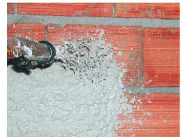
Após projecção regularizar com régua de alumínio de H fechado, de modo a obter uma superfície plana.
