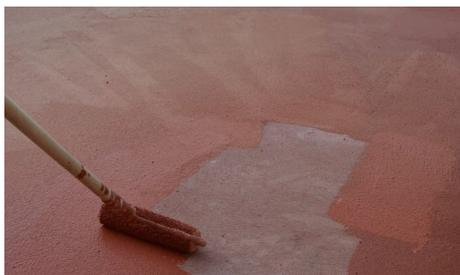
1. Homogenizar bem o Topelastic traffic antes da sua aplicação. Aplicar o Topelastic Traffic com rolo de pelo curto, talocha de inox ou trincha, sobre toda a superfície. Para uma melhor impermeabilização recomendamos a aplicação em três camadas cruzadas, sendo a 1ª camada diluída entre 15-20% (para melhorar a aderência ao suporte) a 2 e 3ª aplicadas sem diluição, respeitando os tempos de espera entre camadas. Intervalo entre camadas é no mínimo de 16 horas.
