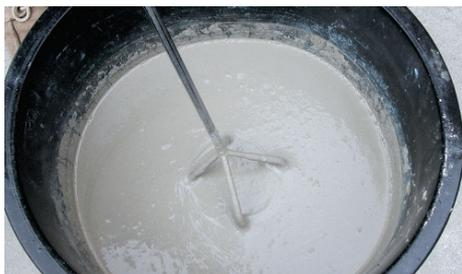
1. Misturar Topcola Flex Basic com cerca de 7,5 litros de água por saco de 25kg, até se obter uma massa com consistência plástica e sem grumos.
