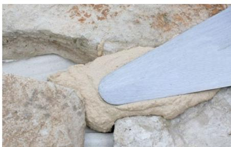
2. Encher bem as juntas com a ajuda de uma colher “língua de gato”. Retirar o excesso de argamassa. Comprimir as juntas com uma colher de juntas quando a argamassa iniciar o endurecimento.
