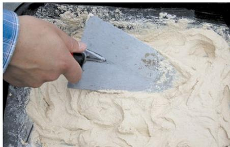
1. Misturar de preferência com um misturador de velocidade lenta, com 3,5 litros (como dado orientativo para uma junta de 10 cm) de água por cada saco de 25Kg.
