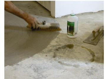
Misturar a betonilha Cem mecanicamente com cerca de 3 litros de água, até obter uma pasta homogênea. A betonilha deverá ficar com a consistência "terra húmida" utilizada para a colagem de cerâmica com nata de cimento.
