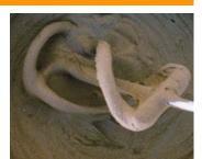
Espalhar sobre o suporte com o auxílio de uma talocha metálica ou espátula, em camadas finas, enchendo e alisando as superficies.
