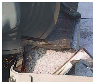
VIGAS DE HIERRO
