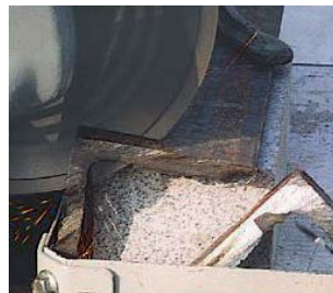
VIGAS DE HIERRO
